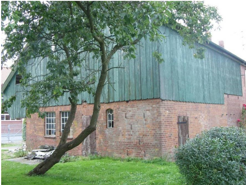
Blick auf den Scheunenteil des umzunutzenden Gebäudes
