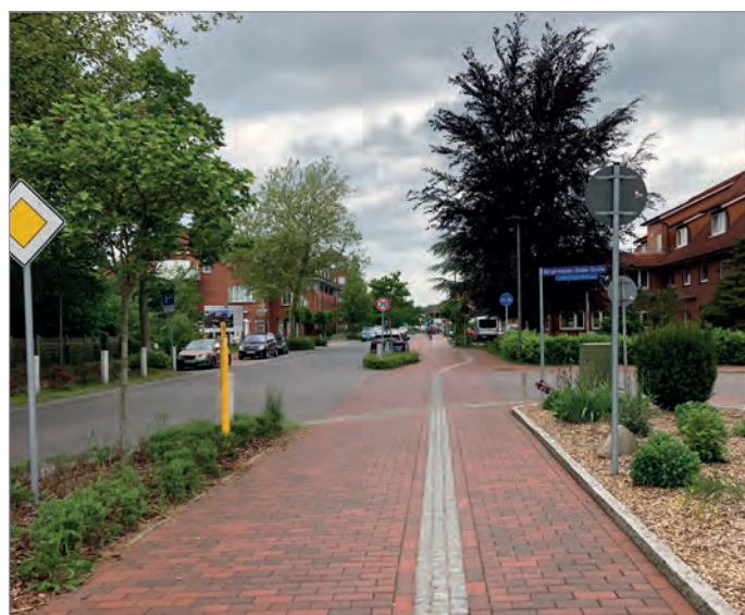
Abbildung 24: Abgrenzung zwischen Gehweg und Fahrbahn in Hemmoor taktil erkennbar
