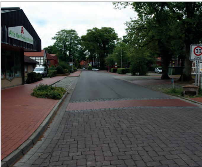
Abbildung 25: Bordabsenkung in Himmelpforten nur auf einer Straßenseite des Überweges vorhanden
