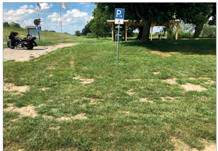
Abbildung 35: Unebener Bodenbelag – Parkplatz Krautsand Strand
