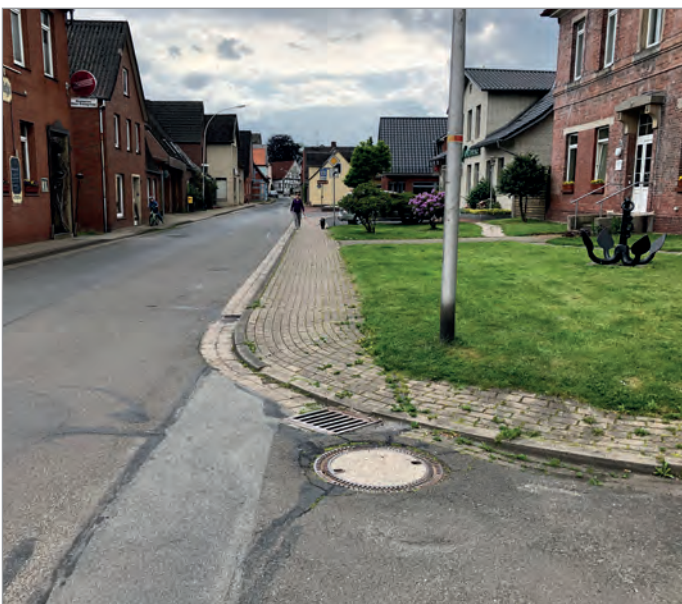
Abbildung 26: Straßenablauf im Bereich der Querungsstelle
