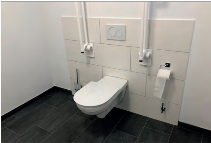
Abbildung 33: Bewegungsfläche auf beiden Seiten des WC im Service-Center Wischhafen
