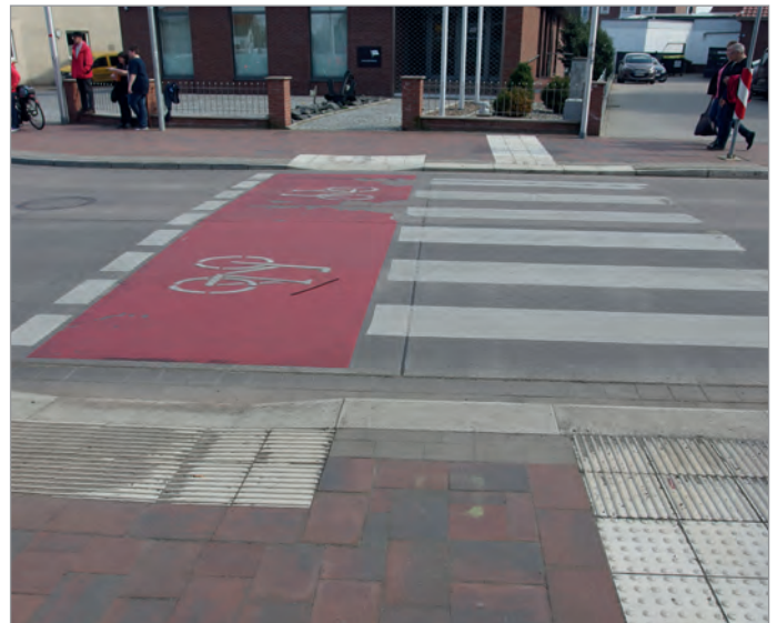
Abbildung 27: Getrennte gesicherte Querungsstelle mit Nullabsenkung für z.B. Rollstuhlfahrende Personen (links) und 6 cm-Bord für blinde Personen (rechts)
