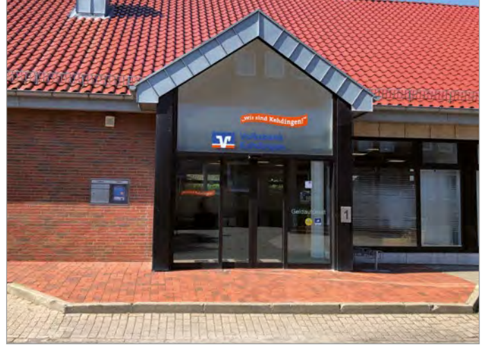
Abbildung 37 und Abbildung 38: Ebenerdige Zugänge zu den Banken in Wischhafen mit unterschiedlicher Türöffnung
